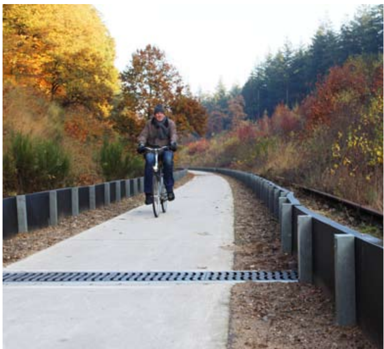
Fietspad door spoorkuil met geleiding en tunnels voor de reptielen
